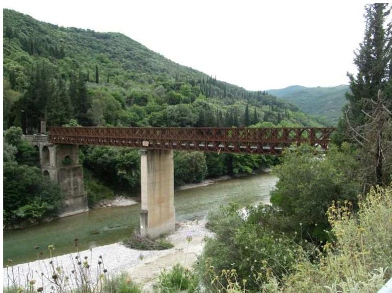
Die Brücke war einspurig mit einer Gewichtsbeschränkung von 16 Tonnen. Aber allein vom Rübergehen gerieten die leicht angerosteten Stahlbleche, die den Boden bildeten, mächtig ins Schwingen.
