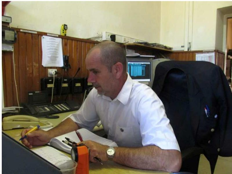
Die Anlage stammt aus den 60er-Jahren und kommt von Siemens. Über der Anlage ist der Fahrplan zu sehen, von links nach rechts ist die Uhrzeit eingetragen, von oben nach unten die Bahnstationen. Bei einer einspurigen Strecke dürfen sich die Linien nur an Punkten kreuzen, wo auch zwei Gleise vorhanden sind.
